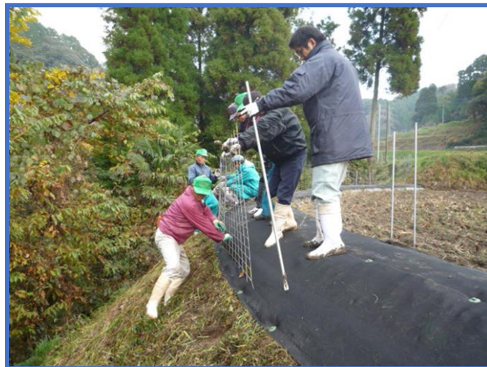
【共同作業でイノシシの侵入を防ぐワイヤーメッシュ張り（富士町）】
