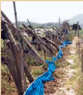
菊電照電柱が倒壊
