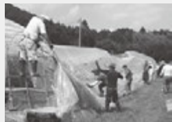
台風で倒壊したハウスの解体作業を手伝う盟友ら
